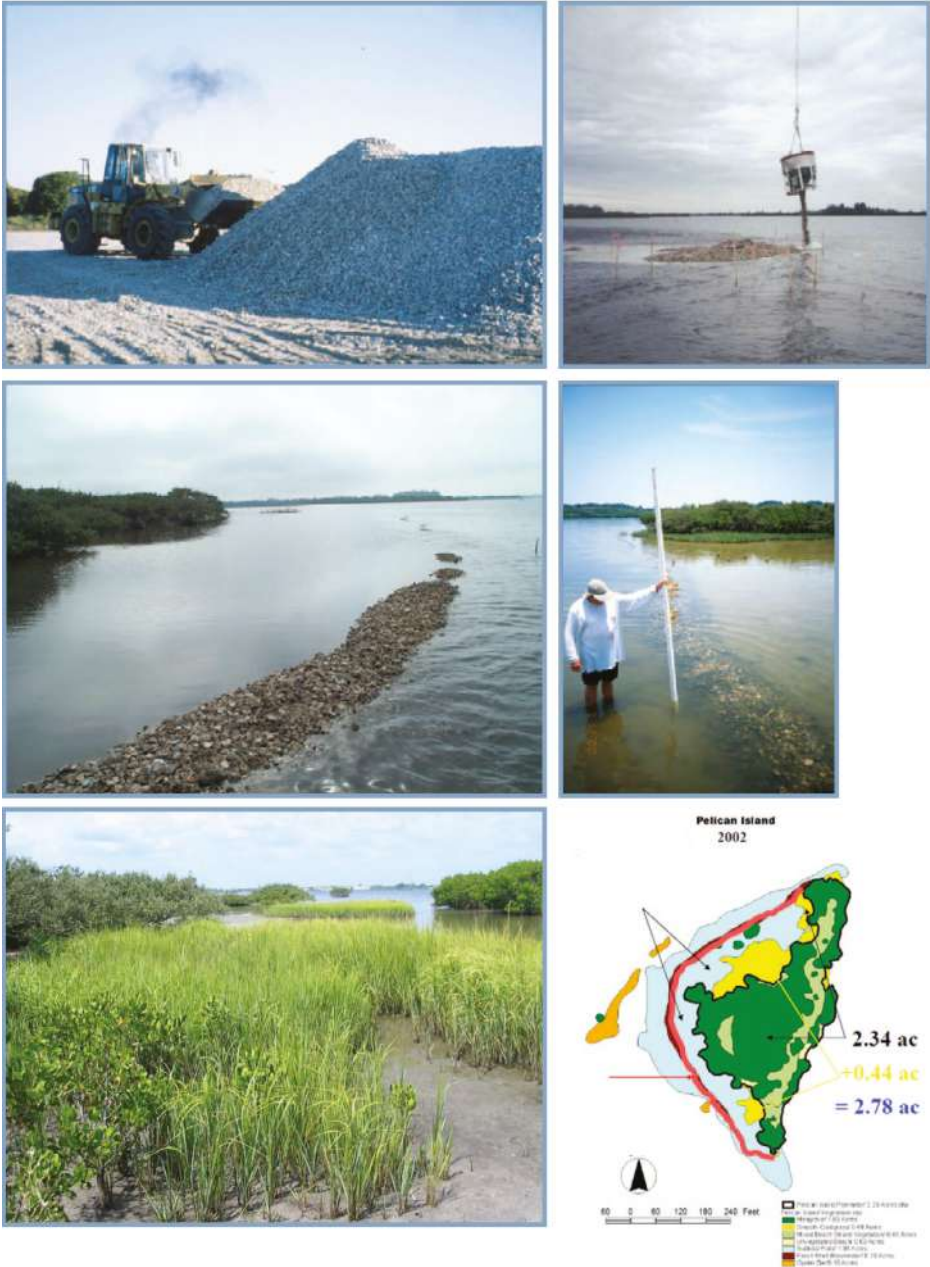
Figura 8.28. Perda de cobertura de manguezal e marisma ao longo do tempo na Pelican Island (A). Um quebra-mar baixo de rocha foi construído (transportado por helicóptero) em 2001 (B-D), resultando na deposição de sedimentos no lado a sota-vento do quebra-mar (E) e no aumento subsequente da cobertura de manguezal e marisma (F-G).
