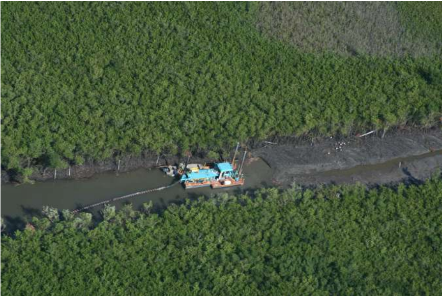
Figura 8.4. Draga flutuante restaurando um canal de maré para melhorar a troca das águas que está causando a morte de manguezais na Baía de Tampa, Flórida, EUA.
