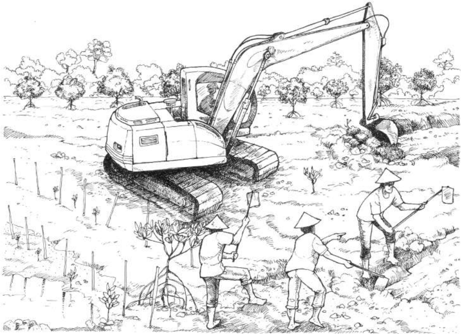
Figura 8.1. Escolha entre o uso de máquinas ou da mão de obra da comunidade. Em projetos de pequena escala (<50 ha) o trabalho manual da comunidade pode ser suficiente, enquanto projetos de grande escala possivelmente exigirão o uso de equipamentos pesados.
