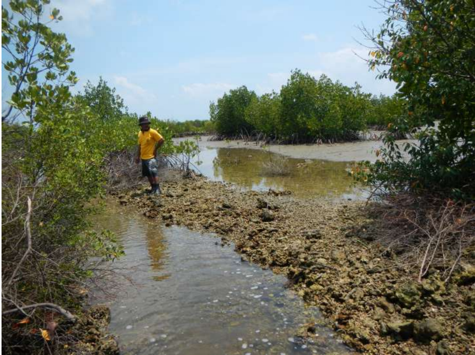
Figura 5.17. Perturbação hidrológica - Embora o muro de dique tenha sido nivelado durante a reabilitação inicial, continua a ser suficientemente alto para bloquear a drenagem do tanque (fundo) para o canal de maré (primeiro plano). Após a identificação durante a monitoramento de que a perturbação hidrológica continua deve ser elaborado plano para melhorar a drenagem, como parte das correções de meio curso.
