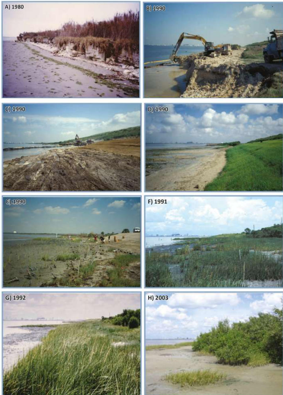
Figura 8.27. Os degraus de erosão vertical indicam erosão severa (A). O degrau de erosão foi desfeito e nivelado para criar um declive estabilizado (B-C). A grama terrestre foi plantada para manter o declive superior, seguida por gramíneas de marisma, que estabilizaram o substrato entremarés (D-G). Treze anos após a intervenção, os manguezais sucederam as marismas. A erosão da linha costeira nesse local não é mais um problema.
